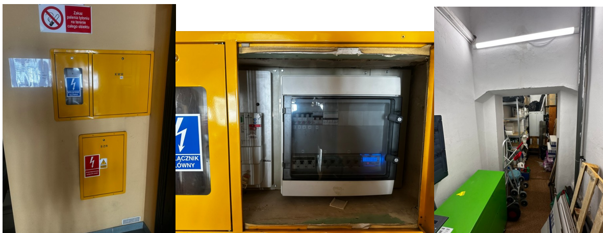
Zdjęcie z lewej i w środku – tablica rozdzielcza, zdjęcie z prawej – pomieszczenie techniczne/gospodarcze – miejsce montażu falownika hybrydowego oraz magazynu energii
