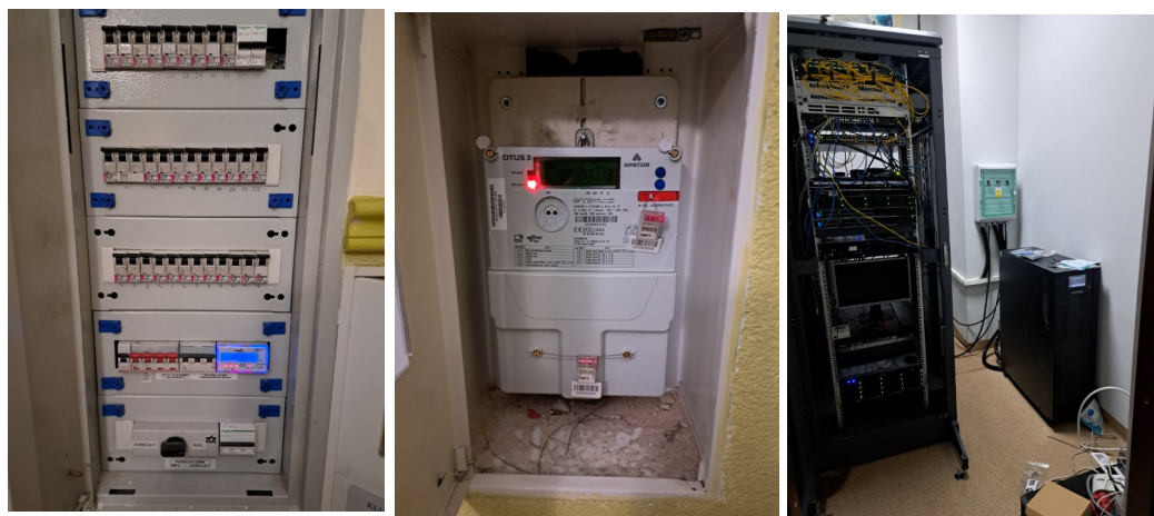
Zdjęcie z lewej i w środku – tablica rozdzielcza, zdjęcie z prawej – pomieszczenie techniczne miejsce lokalizacji falownika hybrydowego i magazynu energii
